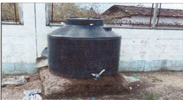
Foto 11: Sustitución depósito de agua cerca de los baños.
