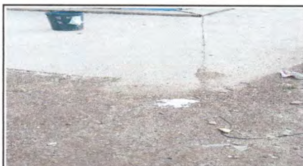
Foto 10: Mantenimiento al sistema de drenaje
