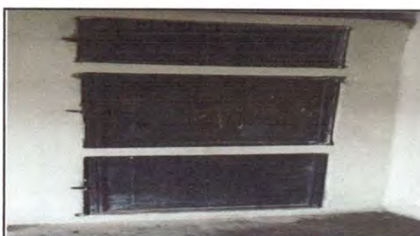
Foto 12: Sustitución de puertas pequeñas.
