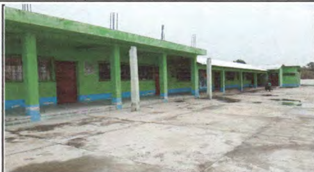
Foto 7: Pintura en muro de interiores y exteriores de 6 aulas.
