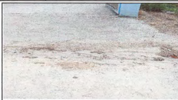
Foto 8: Sustitución de piso de tierra por pavimento frente a la cocina.
