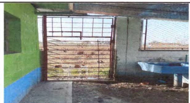
Foto 3: Sustitución de puerta en la entrada de la cocina.
