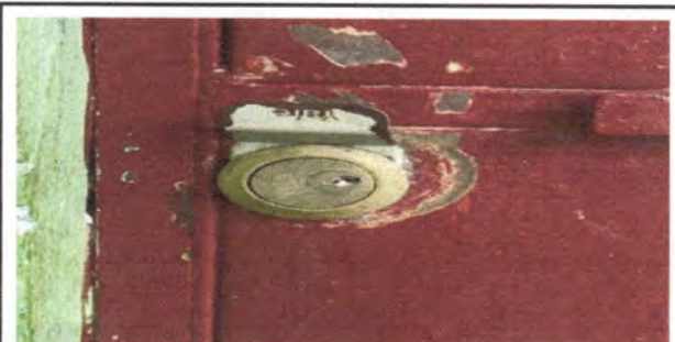
Foto 6: Sustitución de chapas en mal estado por chapas marca Yale.
