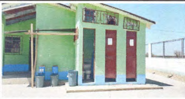
Foto 1: Sustitución de techo de baño y lavamanos
