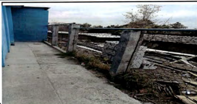
Foto 1: En esta fotografía demuestre que es necesario nivelar los muros e igual el bloks abajo para que sea mas garantizado
