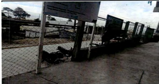
Foto 2: En esta fotografía demuestra tambien colocacion de blok e nivelacion de muros, cambiar mallas.
