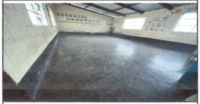
Foto 2: Sustrucción de piso de cemento por piso de granito aula 2
