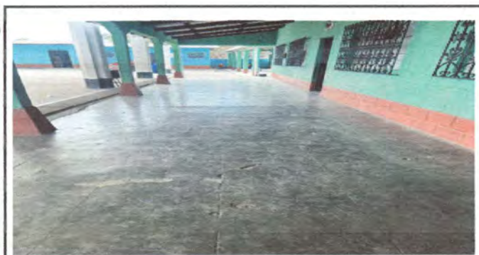
Foto 5: Sustrucción de piso de cemento por piso de granito. Corredor de 2 aulas.
