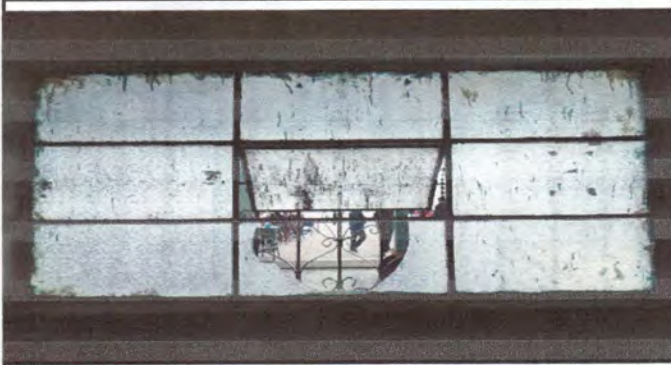
Foto1: Sustrucción de ventanas de dirección por ventanas corredisa.
