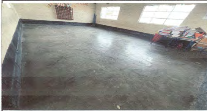
Foto 1: Sustrucción de piso de cemento por piso de granito. Aula 1
