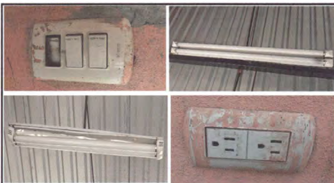
Foto 3: Sustitucion de lamparas, cables, apagadores y toma corrientes
