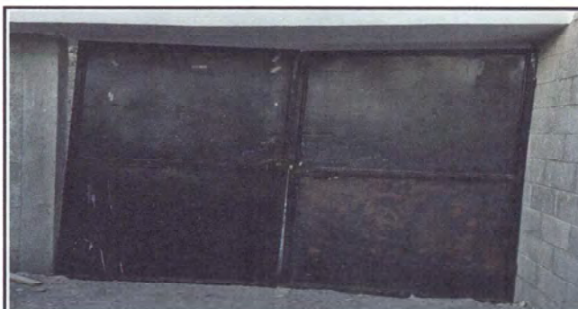
Foto 6: Sustitucion de porton, entrada principal
