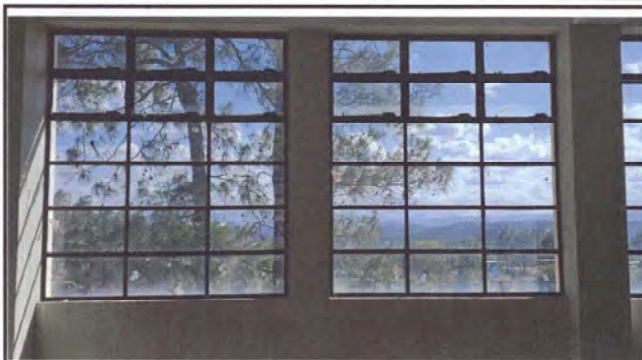
Foto 2: Colocacion de balcones a ventanas
