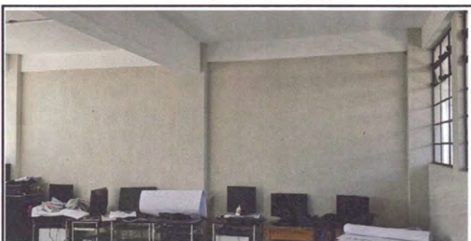
Foto 5: Repintar paredes interior y exterior de las aulas
