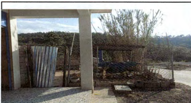
Foto 3: SUSTITUCIÓN DE CERCO PERIMETRAL CON LA INSTALACIÓN DE 2 HILERAS DE DE BLOCK, SUSTITUCIÓN DE MALLA Y PUERTA
