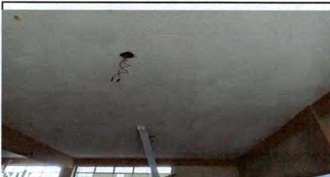
Foto 5: REPARACIÓN DEL SISTEMA ELÉCTRICO EN AULAS Y CORREDOR DEL ESTABLECIMIENTO.
