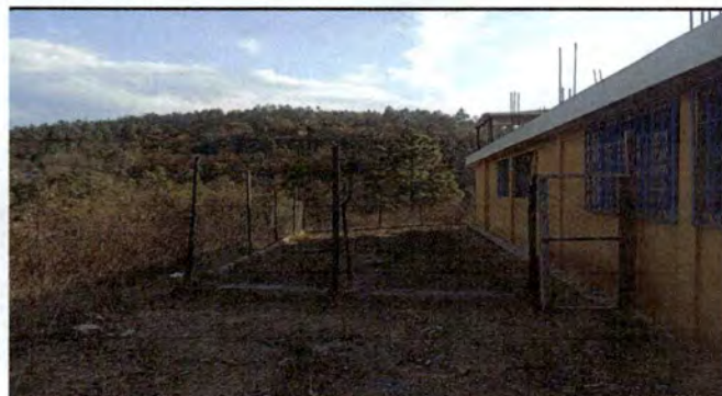
Foto 4: SUSTITUCIÓN DE CERCO PERIMETRAL CON LA INSTALACIÓN DE 2 HILERAS DE DE BLOCK, SUSTITUCIÓN DE MALLA Y PUERTA
