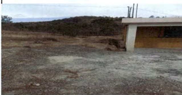
Foto 1: ADOQUINAMIENTO EN LA PARTE POSTERIOR DE LA ESCUELA.
