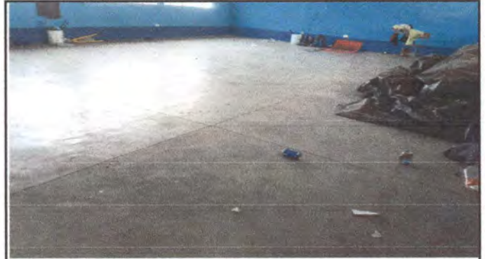
Foto 2: Parte del salón para la sustitucion del piso de cemento por piso de granito.
