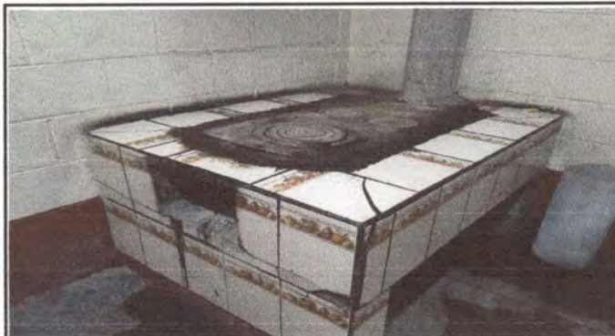
Foto 3: Parte frontal de la plancha de cocina para la susutitucion de ceramica.
