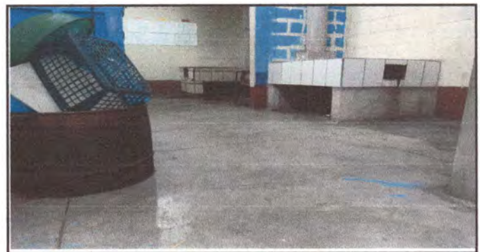
Foto 6: Parte la cocina para la sustitucion del piso de cemento por piso de granito.
