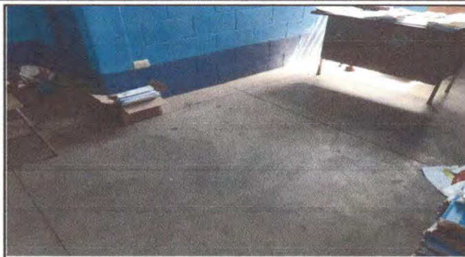
Foto 8: Parte de la dirección para la sustitucion del piso de cemento por piso de granito.
