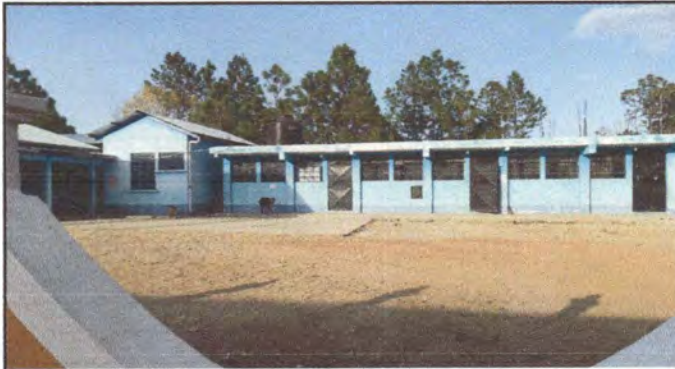
Foto1: Parte frontal de la escuela, para la renovacion de la pintura.
