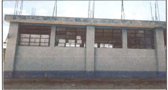
Foto 4: Parte posterior de la escuela para la colocacion de barandas
