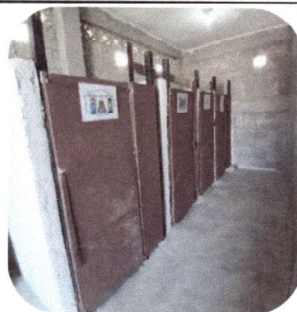
Foto 6: Cambio de puertas en sanitarios
