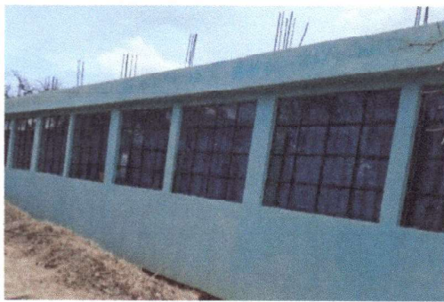
Foto 3: Colocación de valcones y se pintará las aulas
