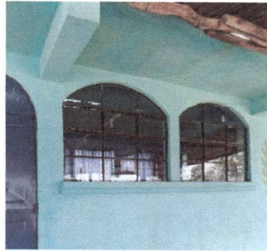
Foto 2: Colocación de balcones en aulas
