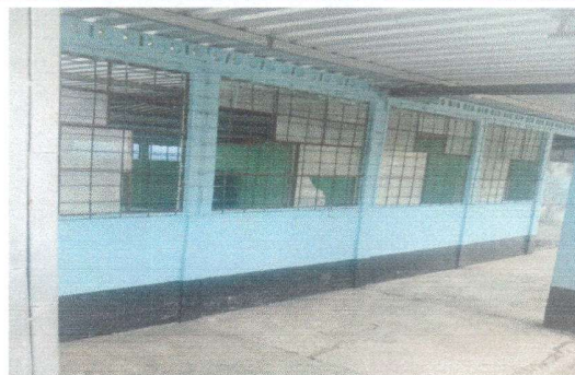
Foto 2: Sustitucion de vidrios, varandas y piso.
