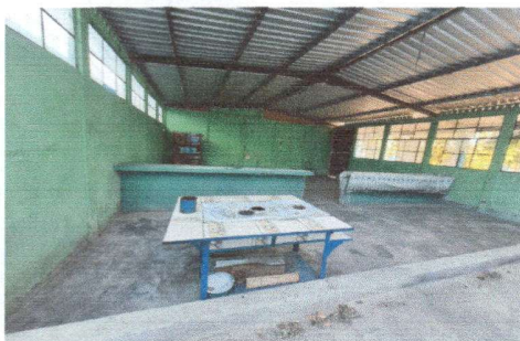
Foto1: Reparación de cocina, reparacion de muro, sustitucion de piso, instalación plancha, instalación chimenea, instalación pila, instalacion de 1 puerta y 2 ventanas
