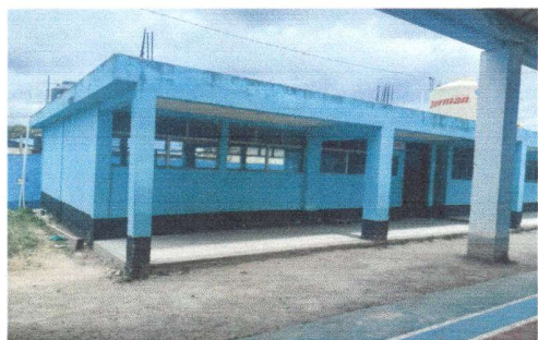
Foto 5: pintada en la parte exterior de las dos aulas
