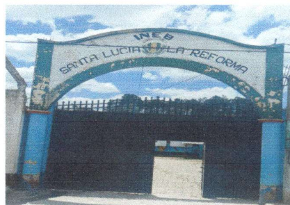
Foto 4: pintada y reparacion de logotipo del establecimiento
