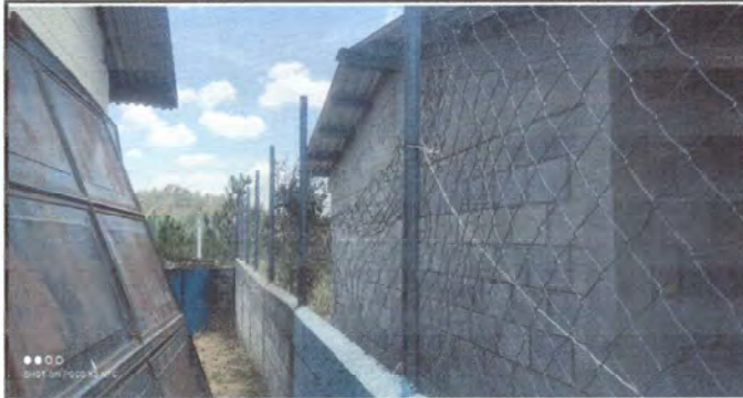
Foto1: vista al área de circulación a reparar desde poniente
