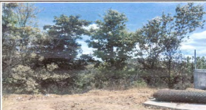
Foto 3: vista al área de circulación a colocación de sistema de blocón desde oriente
