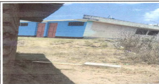
Foto 5: vista al área de circulación a colocación de sistema de blocón desde norte
