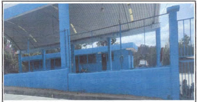
Foto 6: Vista al área de circulación reparar desde norte
