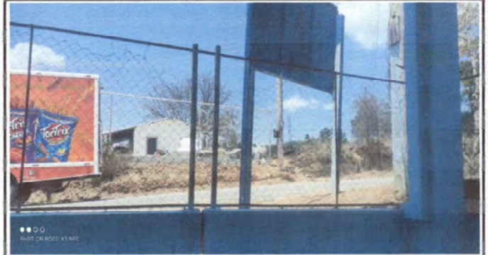
Foto 2: vista al área de circulación a reparar desde oriente
