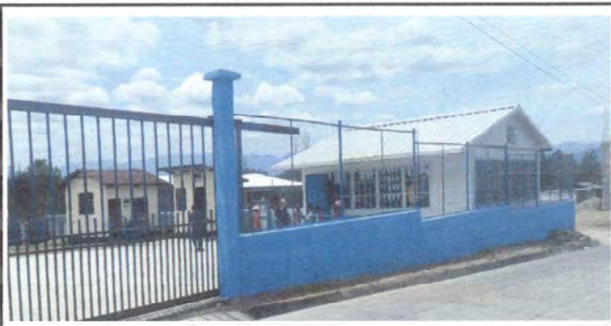
Foto 5: vista al área de circulación a reparar desde norte
