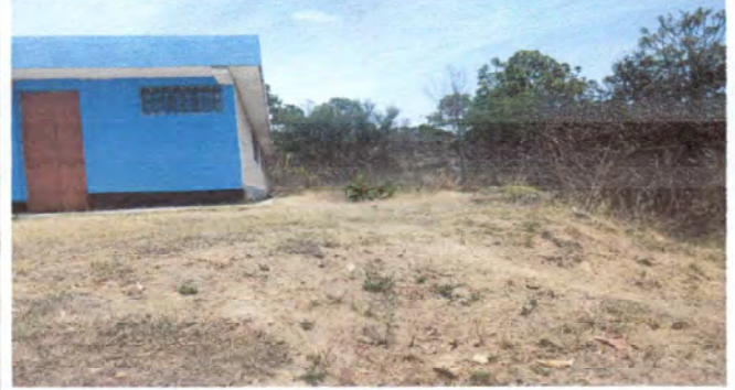
Foto 2: vista al área de circulación a colocación sistema de blocón desde oriente
