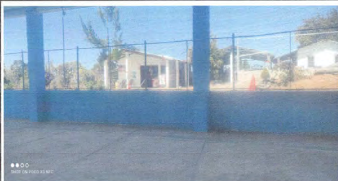
Foto 3: vista al área de circulación a reparar desde oriente
