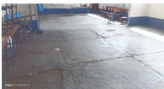
Aula para sustitución de piso
