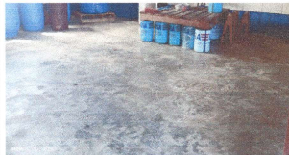
Aula para sustitución de piso
