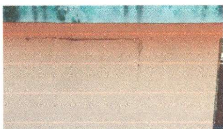
Foto 11: reparación del repello
