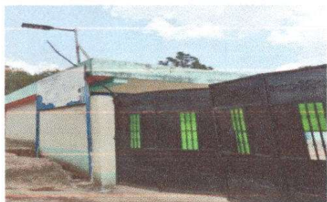
Foto 7: fabricación e instalación de porton
