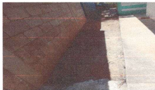
Foto 10: reparación de cuneta
