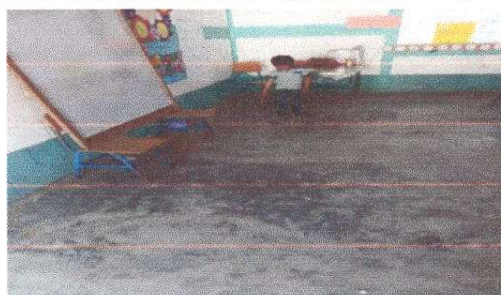
Foto 9: cambio de torta de cemento por azulejo
