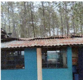
Foto 5: SUSTITUCIÓN DE LAMINA EN COCINA
