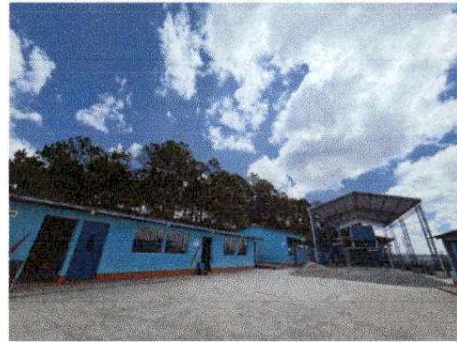
Foto 2: MANTENIMIENTO DE PINTURA EN PAREDES EXTERIORES DE LA ESCUELA
