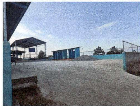
Foto 4: INSTALACION DE PORTAL DE METAL
