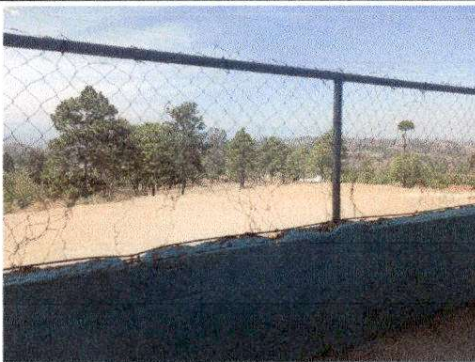
Foto 3: SUSTITUCION DE BARANDAS DE METAL
