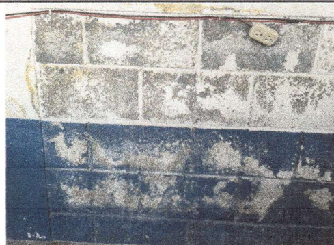
Foto 4: MANTENIMIENTO, PINTURA DE MUROS INTERIORES DE AULAS.
