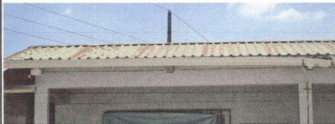
Foto 2: TECHO ESCUELA, LADO DIRECCIÓN
