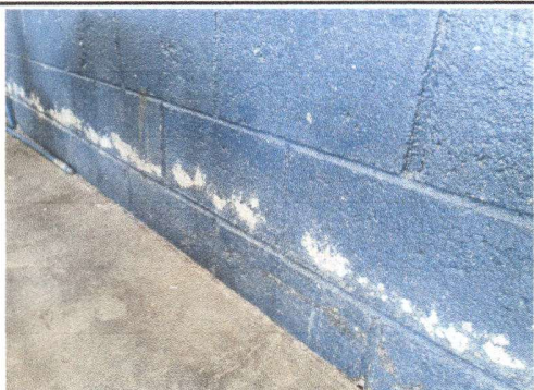
Foto 3: MANTENIMIENTO PINTURA DE MUROS INTERIORES DE AULAS, DIRECCIÓN, COCINA, BODEGAS.
