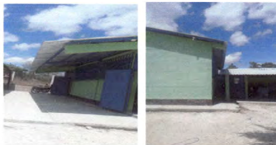
Foto 4: Intalacion de canal de agua pluvial.
