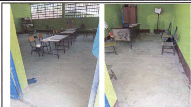
foto7. Sustitución de piso de cemento por piso de ceramica.
