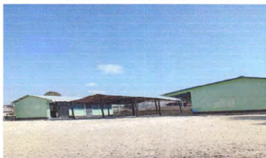
Foto 5: pintada de paredes interior y exterior de aulas bodega y cocina
