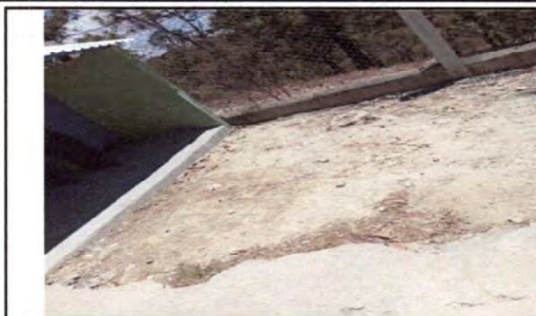
foto 8. Sustitución de piso natural por piso de concreto
