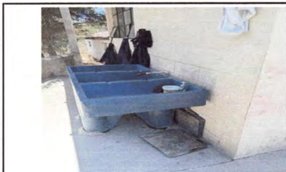
foto 9. Sustitución de pila por lavadero.
