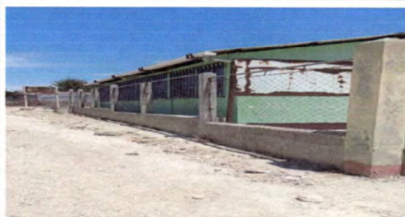
Foto 6: Sustitución de malla en circulación.
