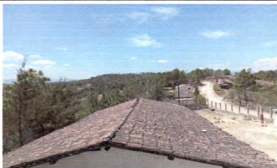
Foto1: vista de cubierto de techo de tejas, se remozara aulas con estructura de tejas
