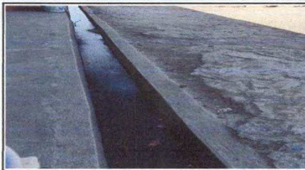
Foto 2: Colocación de rejillas de metal en el perímetro de la cuneta
