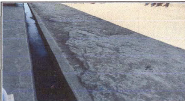
Foto 3: sustitución de losa de patio
