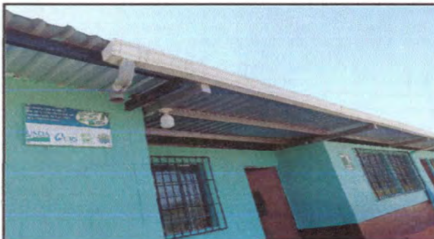
Foto 4: Cambio de canales y tubos de bajadas de agua
