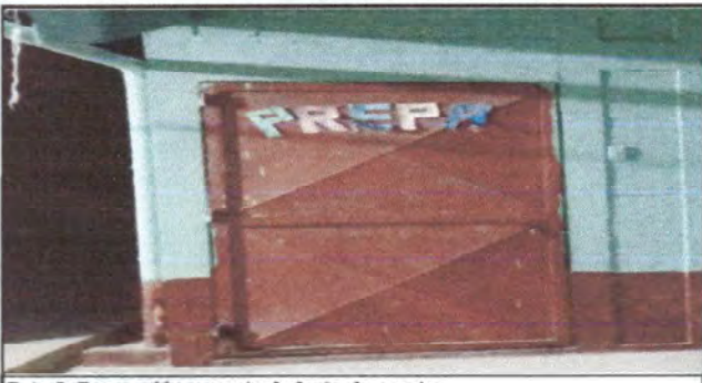
Foto 5: Reparación y mantenimiento de puertas
