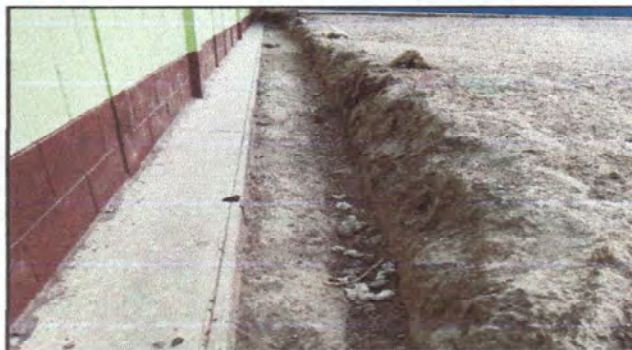
Foto 2: Sustitución de cuneta de tierra por concreto
