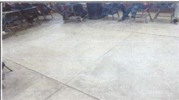
Foto 1: Aula para sustitución de piso de cemento por piso cerámico
