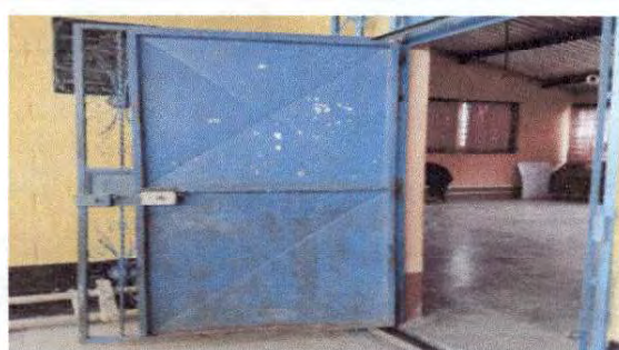
Foto 10: Vista de la puerta de laboratorio de computación pintar y cambiar la parte de abajo. 10/03/2025
