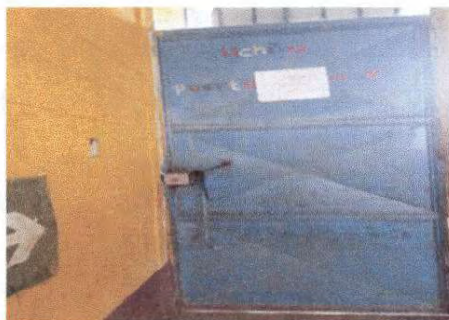
Foto 7: Vista de la puerta de segundo pintar y reparar Chapa. 10/03/2025
