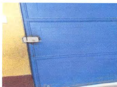
Foto 6: Vista de la puerta de preprimaria pintar y arreglo de chapa. 10/03/2025
