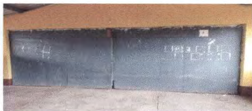
Foto 1: Vista de sustitución de entrepaño 10/03/2025
