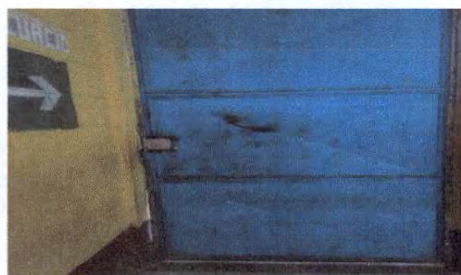
Foto 8: Vista de la puerta de tercero pintar, cambio de chapa y reforzar marco. 10/03/2025
