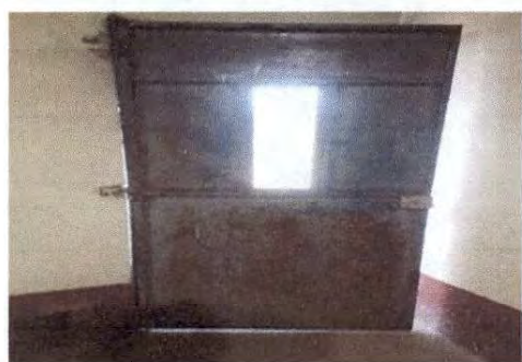
Foto 9: Vista de la puerta de cocina pintar, recortar y cambio de chapa. 10/03/2025
