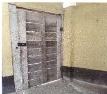
Foto 2: Vista de la sustitución de la puerta de madera a metal de salida alterna del centro educativo 10/03/2025
