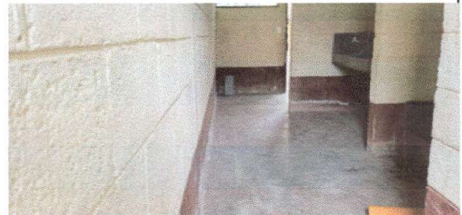
Foto 4: Sustrucción de piso por azulejos..
