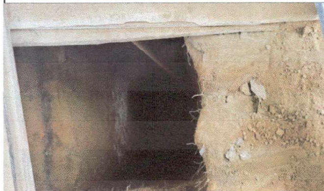
Foto 4: Área donde se sustituirá el Biodigestor.
