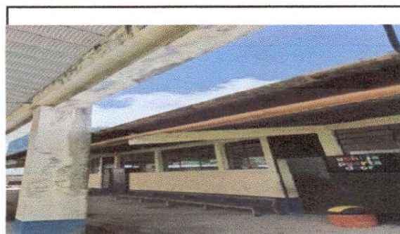
Foto 6: Sustrucción de canales agua pluvial, edificio de dos aulas incluyendo la biblioteca.
