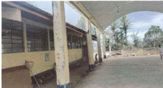
Foto1: Sustrucción de canales agua Pluvial desde otro ángulo
