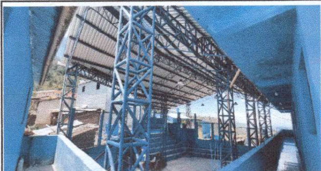
Foto 1: 1.1 Mantenimiento de estructura de techo de patio.
