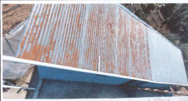
Foto 2: 2.1 Instalación de techo en área entre dos módulos con costaneras.
