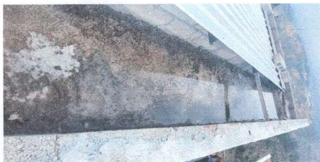
Foto 7: 3.3 Mantenimiento de canal de cemento en techo de 3 aulas.
