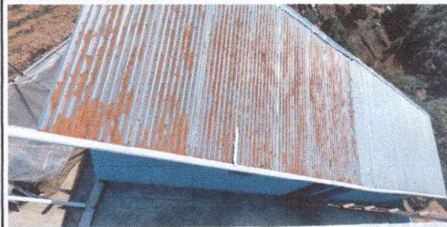
Foto 6: 3.2 Sustitución de canal de PVC alto caudal.
