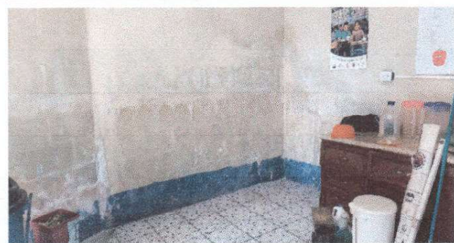
Foto 9: 5.1. Mantenimiento de repello de pared en cocina.
