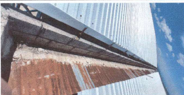
Foto 5: 3.1 Pañuelo en cornisa con bajadas de agua en techo de tres aulas.
