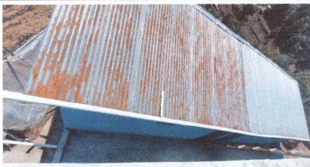
Foto 3: 2.2 Sustitución de láminas acanaladas a troqueladas en bodega.
