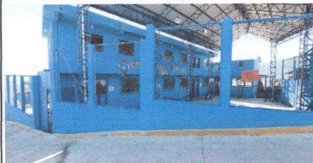
Foto 8: 4.1 Mantenimiento de mallas con lijado y pintura.
