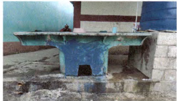
Foto 2: pila en mal estado, ya no cuenta con valvula para resguardar el agua.
