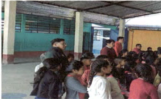
Foto 7: se pretende colocar balcones a dos aulas para protección.
