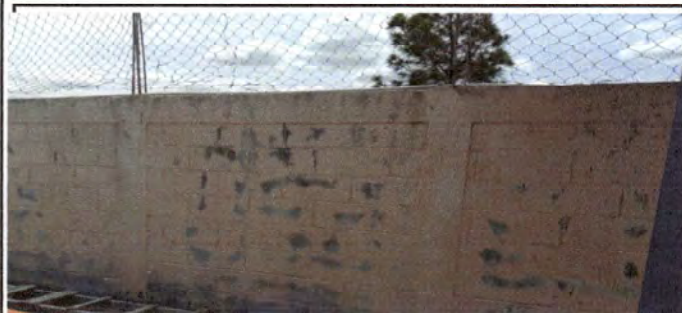
Foto 3: estado de la pintura por ello se decidió pintar y ampliación de cerco con maya.
