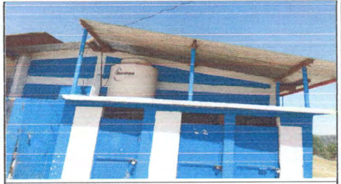
Foto 2: Sustitución de tinaco
