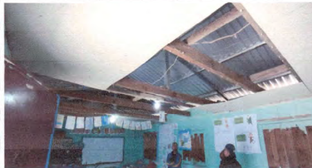
Foto 2: Reparación de la estructura de techo con la instalación de Cielo Falso UPVC
