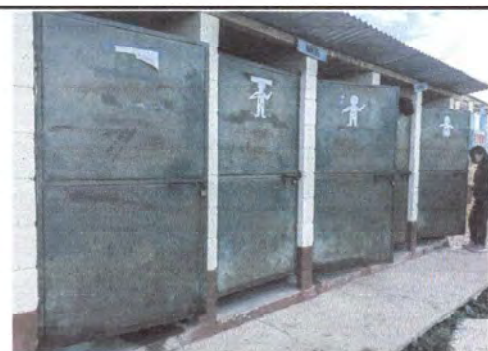
Foto 5: reparacion y pintura
