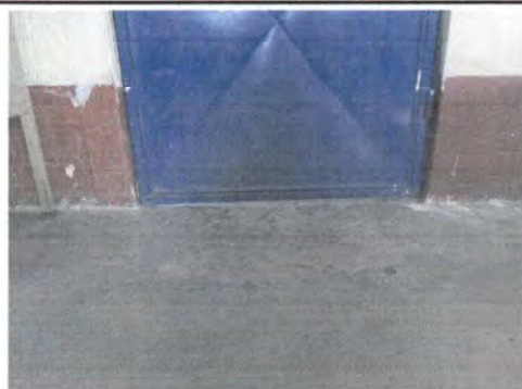
Foto 2: reparación y pintura
