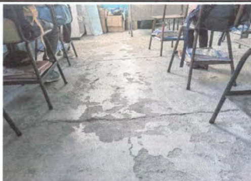
Foto1: sustitución de pisos de cemento por piso ceramico de 6 salones y una direccón.
