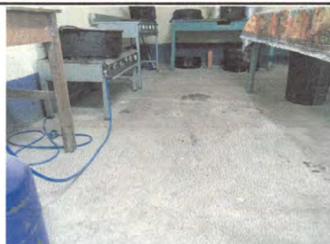
Foto 4: sustitucion de pisos de cemento por piso granito blanco y negro
