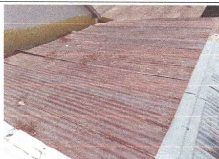
Foto 5: Las láminas de un módulo de dos aulas se encuentran en las estado y cuando llega el invierno estas gotean dentro del salón.
