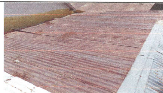
Foto 6: Cambio de las láminas oxidadas del módulo de dos aulas por láminas troqueladas y capotes.
