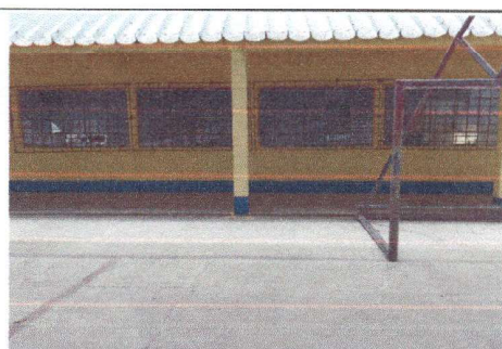
Foto 4: Sustitución de ventanas de un módulo de cinco aulas de 18 ventanas, un módulos de dos aula en la parte de enfrente con tre ventanas y un módulos de dos aulas con cuatro ventas, los valocones
