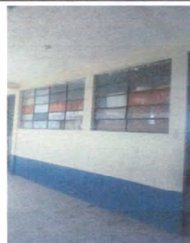
Foto 2: Módulo II Ventanas del aula de la seño Francisca parte frontal (2).
