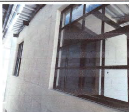
Foto 16: Módulo V Ventanas (2) de la cocina a un costado.
