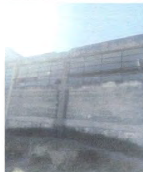
Foto 4: Módulo II Ventanas del aula de la seño Perla parte de atrás (2).
