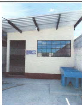
Foto 15: Módulo V Ventana (1) de Cocina parte frontal.
