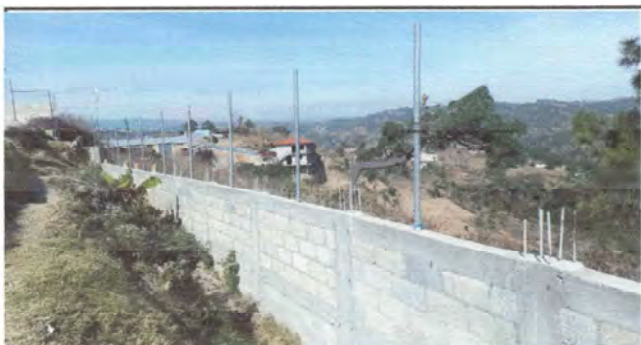
Foto 17: Colocación de Malla en el muro perimetral.
