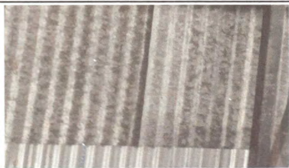
sustitucion de estructura de techo negra a tubo galvanizado
