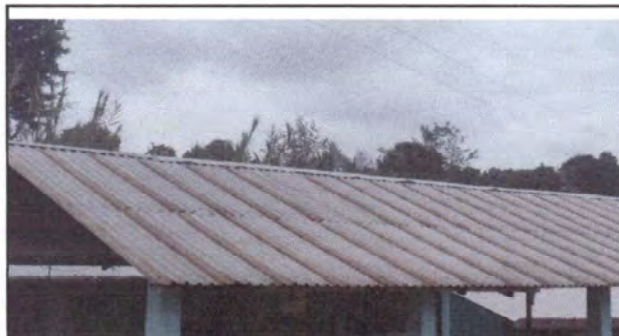
Sustitución de lamina acanaladas a laminas a troquela calibre 26
