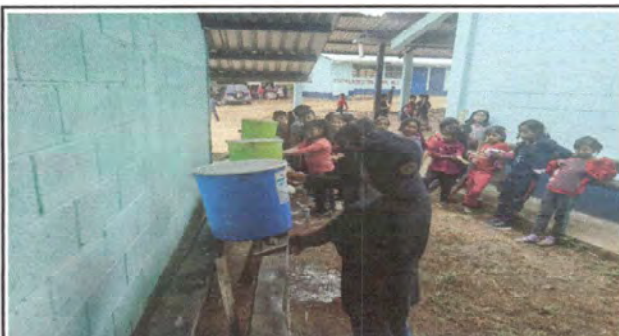
Sustitución de lavamanos
