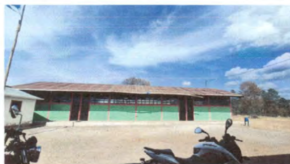
Foto 2 balcones para 4 aulas para proteger los vidrios y mas seguro.
