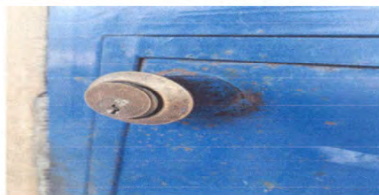
Foto 5: Remoladacion de la chapa de la puerta de un aula.
