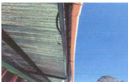
Foto 9: Lampara led,colocacion luz electrico porque es necesario.
