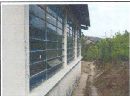
Foto 7: La instalación de balcones consiste en la colocación de estructuras en un aula.
