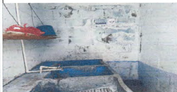
Foto 5: Remoladacion pared de la pila, por humedad de la pared
