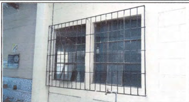
Foto 1: Cambio de ventanales de cocina lado derecho
