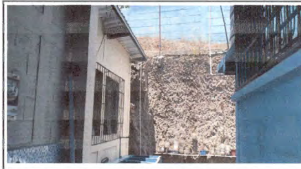
Foto 10: Colocación de techo para pila de cocina, vista lado lateral
