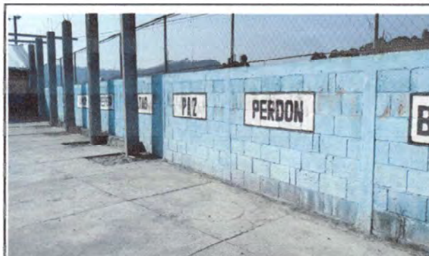
Foto 12: pintada de muro, vista al patio
