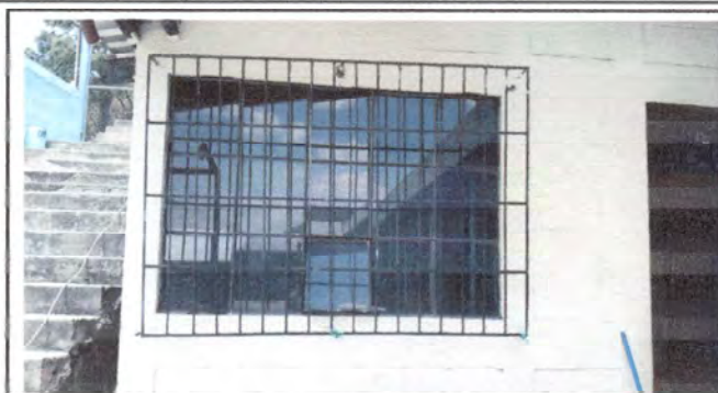
Foto 2: Cambio de ventanales y ampliación de cocina lado frontal
