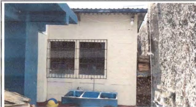
Foto 9: Colocación de techo para pila de cocina, vista lado frontal
