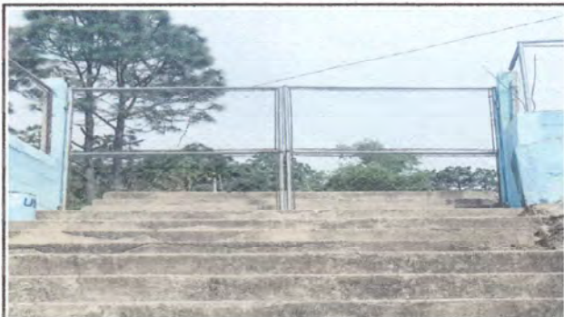
Foto 7: Cambio de portón, vista interior de la escuela
