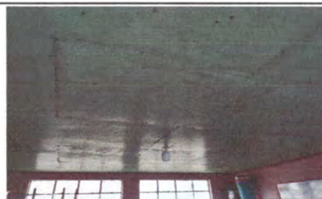
Vista de sustitución de cielo falso anterior de cielo falso 4 lámparas y conexión de electricidad.
