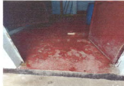
Vista Colocación de piso cerámico en baño de hombres antideslizante.
