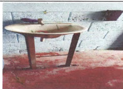
Vista de Sustitución de 4 lavamanos.
