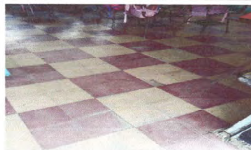
Vista de sustitución de piso mosaico por piso cerámico en un aula.
