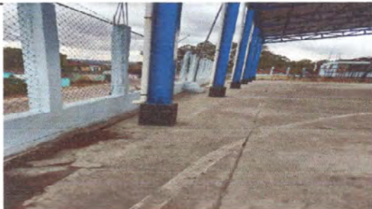
Vista Sustitución de malla por rejas de tubo rectangular
