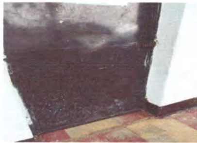
Vista Sustitución de 1 chapa Yale
