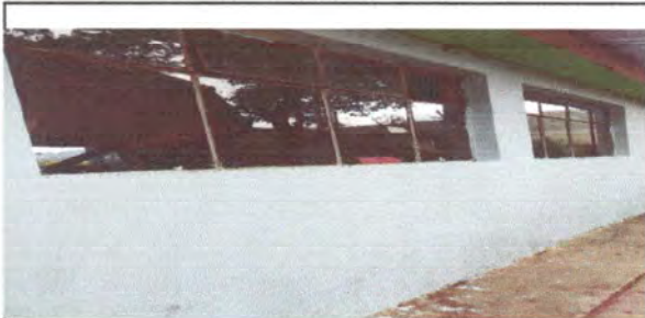
Vista Sustitución de vidrios en 2 vidrieras de metal en un Aula
