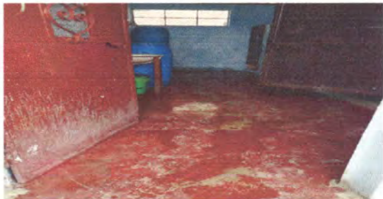
Vista Colocación de piso cerámico en baño de mujeres antideslizante.
