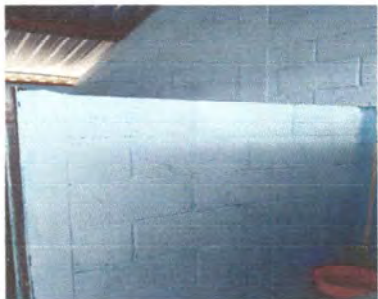
Vista de Colocación de de azulejo en 2 baños en paredes de block
