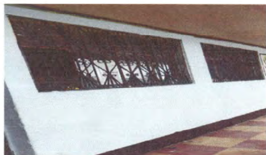
Vista de sustitución de vidrios en 2 vidrieras de metal en un Aula pintada de Vidrieras
