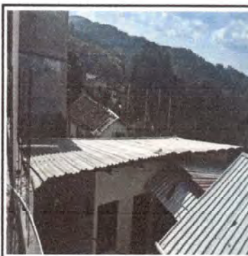
Foto 4: Vista del techo de cocina y bodega a sustituir con cosntaneras y laminas troqueladas
