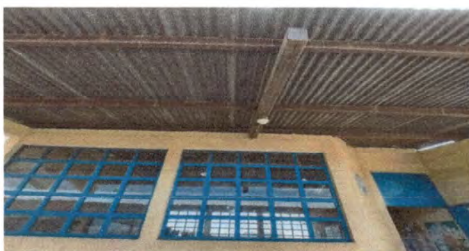
Foto 6: Fotografía de vigas de aula a pintar.
