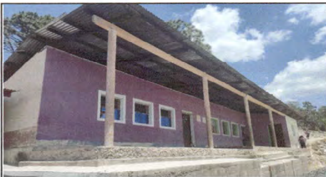
Foto 3: Cambio de techo para tres aulas, lamina troquelada calibre 26
