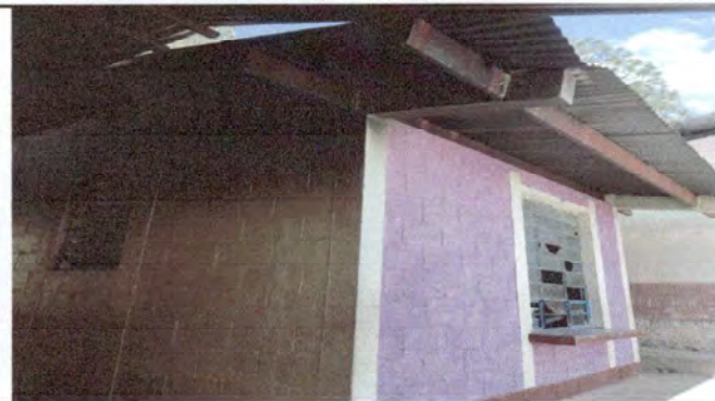
Foto 1: cambio de techo de cocina, vidrios de la parte frontal, lateral y de atrás, también pintado de costanera y cambio de chapa y pintura de la puerta
