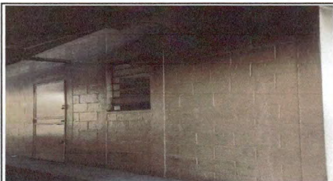
Foto 3: Mantenimiento mediante trabajos de albañilería en área de cocina, consistentes en la demolición de muro existente
