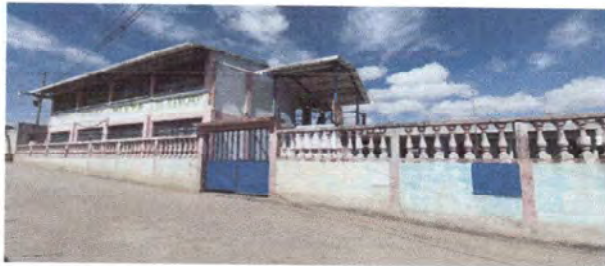
Foto1: MÓDULO 1. Pintura para muros y paredes exteriores del edificio escolar, incluye suministro de materiales y mano de obra
