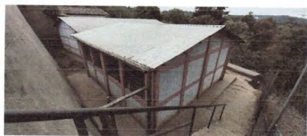
Foto 2: MÓDULO 2. Pintura para paredes exteriores del edificio escolar, incluye suministro de materiales y mano de obra
