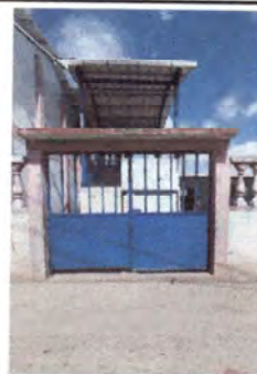
Foto 4: Sustitución de Portón Principal
