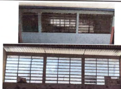
Foto 6: Mantenimiento de marcos de ventanas, consistente en lijado y pintura, incluye suministro de materiales y mano de obra (12 unidades de dos aulas)
