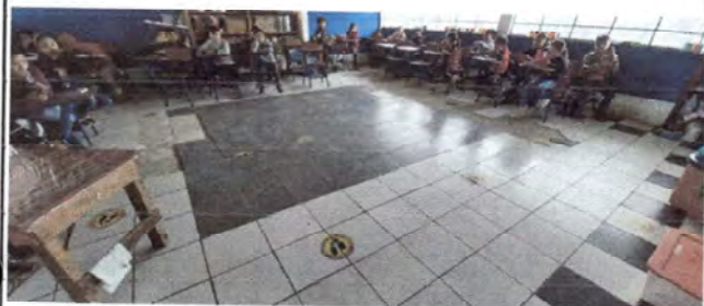
Foto 1: Sustitución de piso en mal estado por piso tipo cerámico en un aula, incluye suministro de materiales y mano de obra
