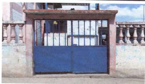
Foto 3: Reparación de estructura portante de portón principal, incluye suministros de materiales y mano de obra
