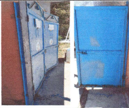
Foto 1: Sustrucción de marcos oxidados y pintura de puertas de baños
