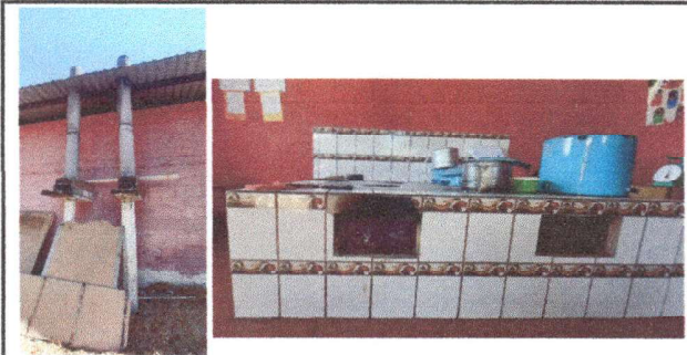
Foto 6: Sustrucción de tubos de chimenea y reparación de 1mts de azulejo
