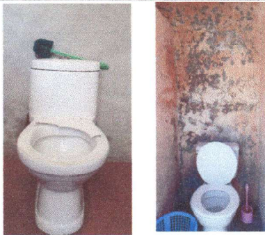
Foto 3: Sustrucción de 1 tapadera de baño, e impermeabilización de pared de baño.
