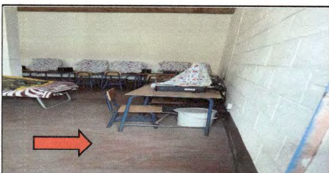
Foto 6: colocacion de piso ceramico
