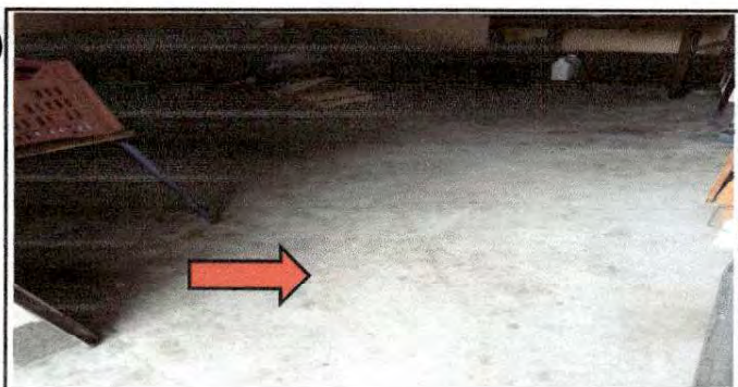
Foto 5: colocacion de piso ceramico
