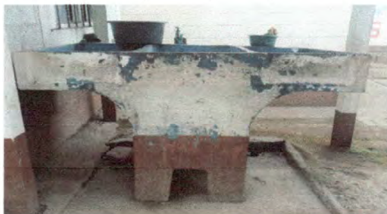
Foto 5: Vista y sustitución de pila
