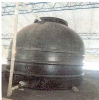
Foto 3: Sustitución de depósito de agua 1250 lt
