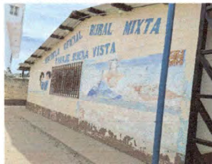
Foto 2: Vista de muros. Pintura en muros exteriores e interiores 1600 metros cuadrados
