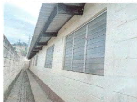
Foto 4: Vista e instalación de balcones en aulas en total 25 metros cuadrados
