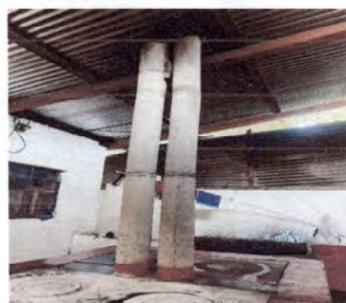
Foto 4 Suministro y sustitución de tubo de cemento para chimenea de estufa rural existente. (módulo cocina).
