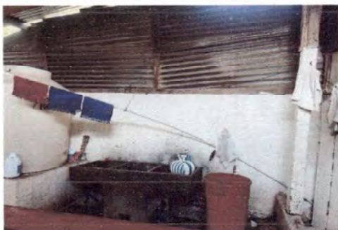
Foto 1, Suministro y reparación de pared de cocina existente. (módulo de cocina).
