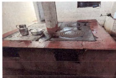
Foto 2 Suministro, reparación de azulejos en estufa rural. (módulo de cocina)
