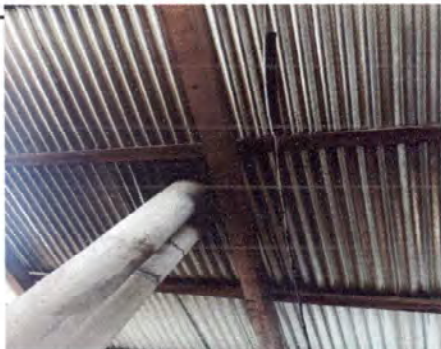
Foto 3 Suministro y sustitución de estructura de madera a estructura de metal galvanizado portante de techo. (módulo de cocina).
