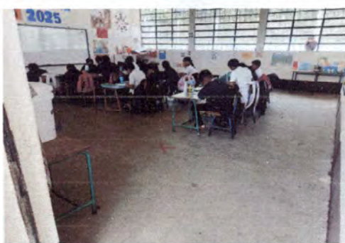
Foto 8: Suministro y sustitución de piso de torta de cemento existente a piso de granito de mármol (modulo de aula No. 2).
