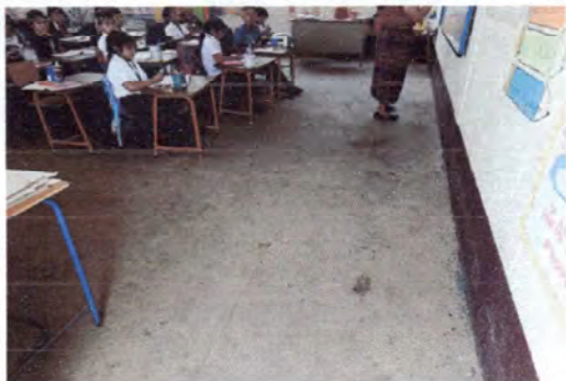
Foto 7: Suministro y sustitución de piso de torta de cemento existente a piso de granito de mármol (modulo de aula No. 1).
