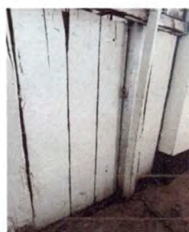
Foto 6 Suministro y sustitución de puerta de madera existente a puerta de metal de 0.90 m a 2.00 m de altura. (módulo de cocina).
