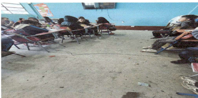
Foto 5: Vista en el aula de sexto primaria, con el piso de torta de cemento en mal estado.
