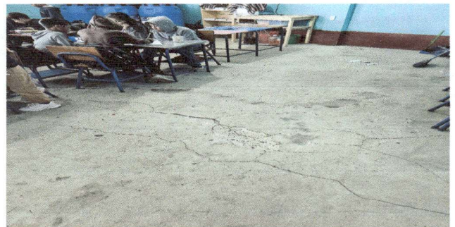
Foto 6: Vista del aula de quinto primaria, con el piso de torta de cemento en mal estado.
