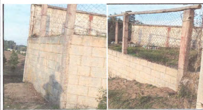
Foto 5: Sustrucción de Muro de Contención: Las paredes del mismo se encuentran agrietadas y las bases de concreto no tienen cimiento, lo que ha causado un deterioro y filtración de agua, cuando llueve.
