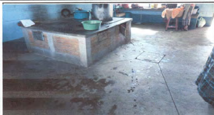
Foto 7. Colocación de piso cerámico: Actualmente la cocina cuenta con una torta de cemento, el cual necesita ser modificado para evitar polvo cuando se barre.
