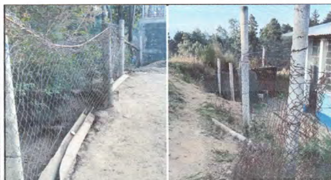
Foto 3: Sustrucción de Malla para Circulación de 42 metros (incluye): La circulación del centro educativo es uno de los principales problemas, pues debido al tiempo que tiene, suele ser inseguro.
