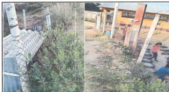
Foto 4: Remodelación de Muro Perimetral (8 metros): Debido a que el muro solo cuenta con una hilada de block, la malla resulta ser muy pesada, tomando en cuenta que los paralelos tienen una distancia de casi 3 metros.
