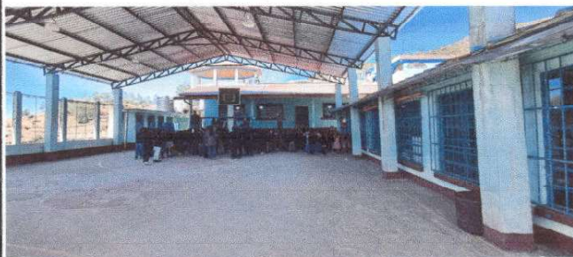
Foto 6: SUMINISTRO Y APLICACIÓN DE PINTURA DE COLOR AZUL HORIZONTE LÁTEX MARCA COVER PLUS LA PALETA, EN EXTERIOR DEL EDIFICIO ESCOLAR.
