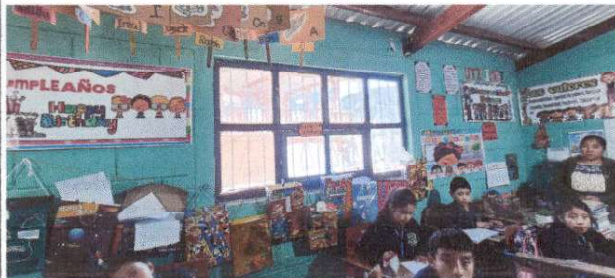
Foto 2: SUSTITUCIÓN DE SEIS VENTANAS DE MADERA POR VENTANAS DE METAL POR SEGURIDAD Y VENTILACIÓN, QUE INCLUYE MANO DE OBRA Y MATERIALES
