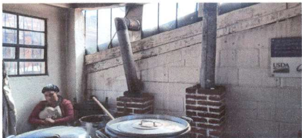
Foto 1: SUSTITUCIÓN DE DOS CHIMENEAS DE METAL EN MAL ESTADO POR DOS CHIMENEAS DE LADRILLO TAYUYO EN PLANCHAS DE LEÑA. QUE INCLUYE MANO DE OBRA Y MATERIALES
