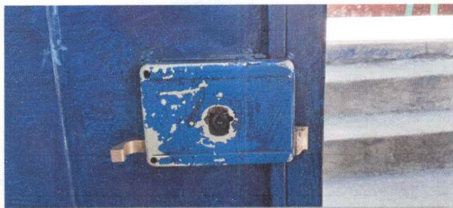
Foto 3: CAMBIO DE LA CERRADURAS O CHAPAS EN MAL ESTADO EN CUATRO PUERTAS DE METAL SIENDO EN AULAS EXISTENTES DEL EDIFICIO ESCOLAR, INCLUYE MATERIALES E INSTALACIÓN
