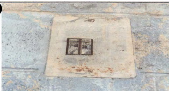
Foto 5: Sustrucción de flifones, cableados y tableros, en general
