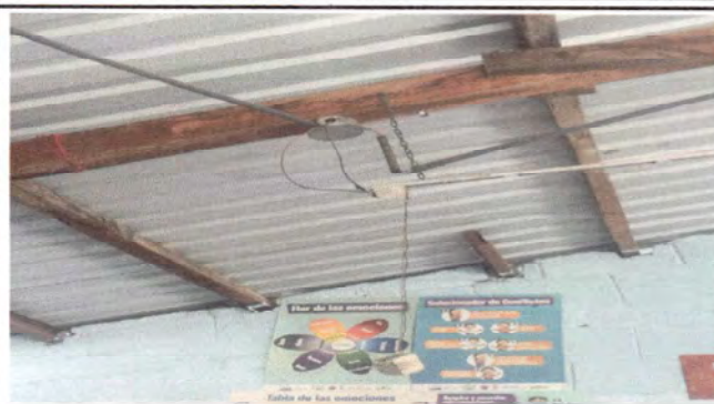
Foto 2: Sustrucción de cajas, flafoneras gasneones por focos led en todo el centro educativo.
