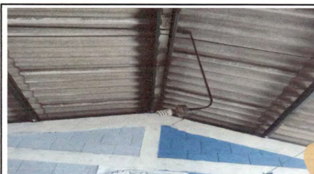
Foto 6: Sustitución de lamparas en todo el establecimiento.
