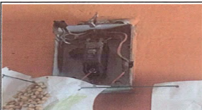
Foto 3: Sustitución de flípones y cableados
