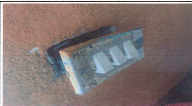
Foto 1: Sustrucción de apagadores en todo el centro educativo y cableado de alimentación.
