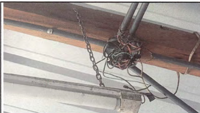
Foto 2: Sustitución de cableado general, cajas, gasneones y tuvos dentro de todas la aulas y el salón del establecimiento.
