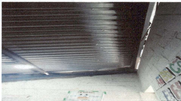
Foto1: Sustrucción de techo, en un aula Módulo 1
