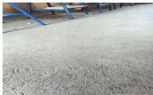
Foto 2: Sustrucción de piso de cemento a piso cerámico, porcelanato 4 aulas módulo 1
