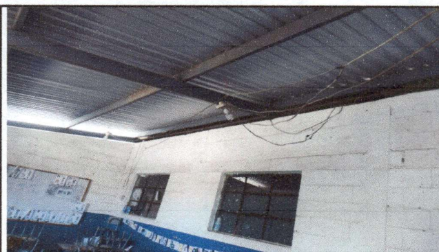
Foto 4: Reparación de sistema eléctrico módulo 1
