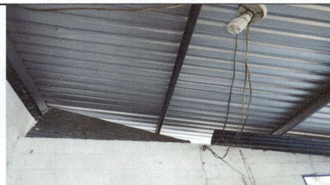
Foto 3: Reparación de muro 2 hiladas de block en dos aulas modulo 1
