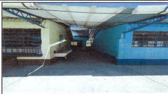
Foto 2: Vista del area donde se instalara la reja del pasillo de la entrada de dirección.
