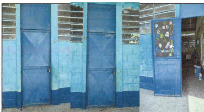
Foto 3: Foto 3: Vista de las puertas de los grados de Cuarto "A". Quinto, Sexto a sustituir
