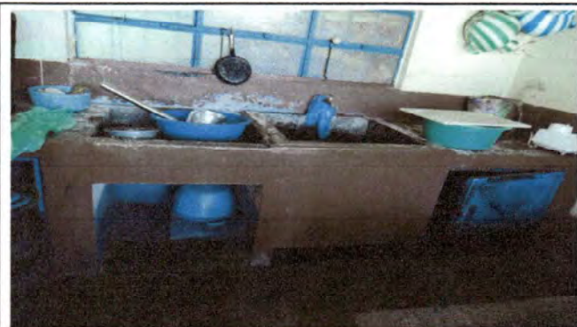
Foto 9: Vista de la pila de la cocina a remozar poniendole azulejos
