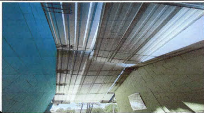
Foto1: Foto1: Vista del area de las laminas de la entrada de dirección a remozar
