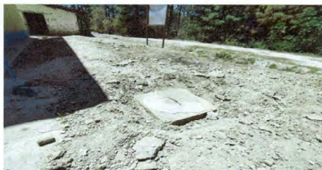
Foto 8: Vista de la fosa septica a darle mantenimiento
