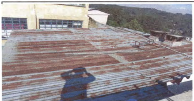
Foto 5: Sustitución del techo de lámina de la cocina por lámina troquelada
