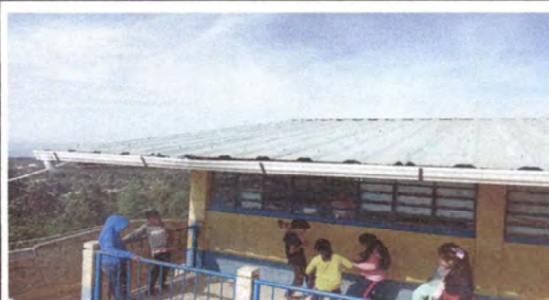
Foto 2: Cambio de Canales de los dos lados del edificio escolar.
