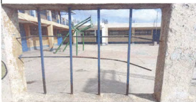
Foto 3: Aquí se realizará el cambio de balcones que están a la orilla de la calle
