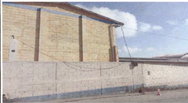
Foto 4: Se pintará la parte exterior del Edificio escolar y el muro perimetral de la calle.
