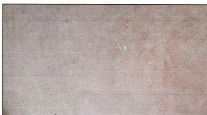
Foto 4: Cambio de piso Aula 2
