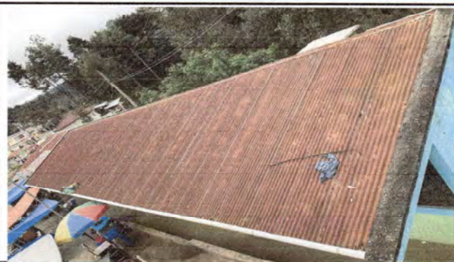
Foto 2: cambio de techo en 2 aulas y direccion por laminas en mal estado.
