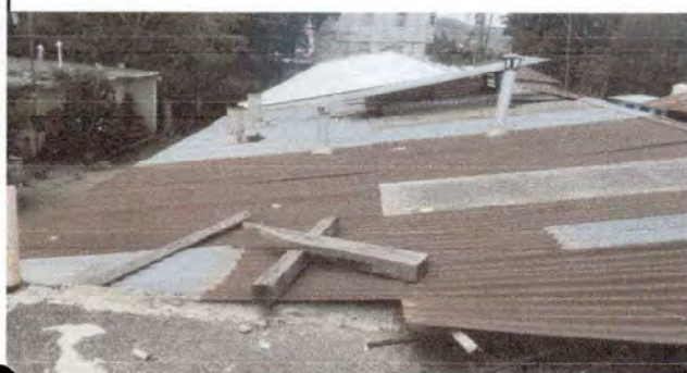
Foto 1: Cambio de techo en cocina por laminas en mal estado y estructura en mal estado.
