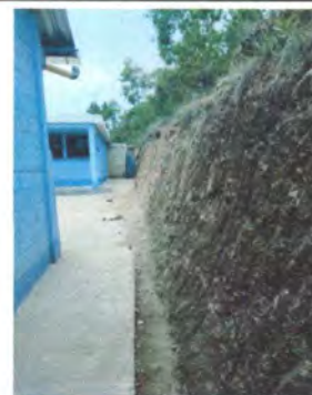
Foto 8: VISTA DE DONDE SE REALIZARÁ REPARACIÓN DE LA CUNETAS
