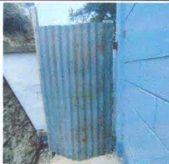
Foto 13: VISTA DE DONDE SE SUSTITUIRA PUERTA DE LAMINA NÚMERO 2
