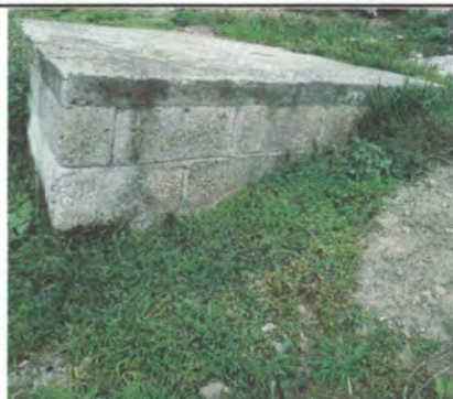
Foto 1: VISTA DE DONDE SE REALIZARÁ EL VACIADO DE FOSA SÉPTICA
