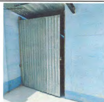
Foto 16: SUSTITUCION DE PUERTA DE LAMINA DE BODEGA DE LEÑA
