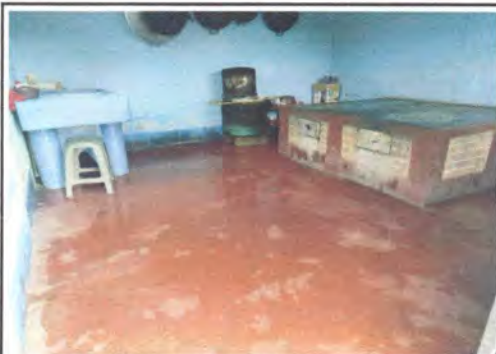
Foto 3: VISTA DE LA COCINA EN DONDE SE REALIZARÁ SUSTITUCIÓN DE PISO, REPARACIÓN DE TUBOS, AZULEJO EN PLANCHA, Y AZULEJO EN SOLERA INTERMEDIA
