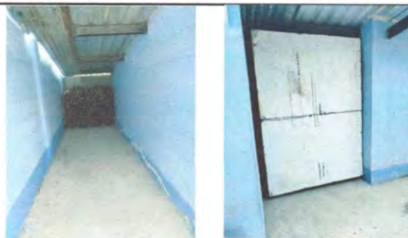
Foto 4: VISTA DE LA BODEGA DE LEÑA DONDE SE REALIZARÁ LA SUSTITUCIÓN DE TECHO Y CAMBIO DE PUERTA.
