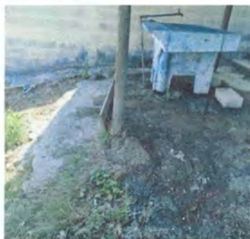
Foto 7: VISTA EN DONDE SE REALIZARA REPARACIÓN DE PISO DE CONCRETO
