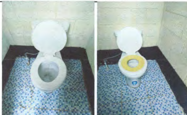
Foto 2: VISTA EN DONDE SE REALIZARÁ LA SUSTITUCIÓN DE TAZAS
