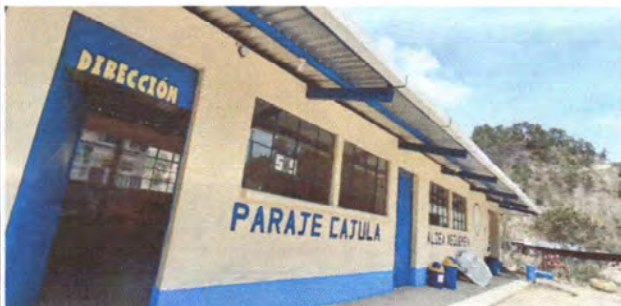
Foto 3: Vista donde se instalará balcones.
