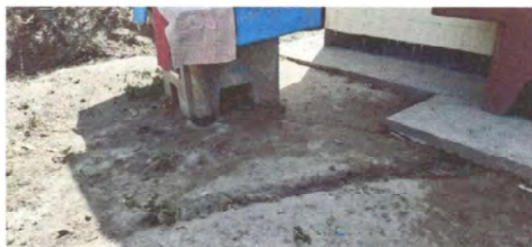
Foto 3: Vista donde se realiza reparación de drenaje.
