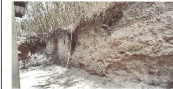
Foto 1: Vista donde se instalará la circulación.
