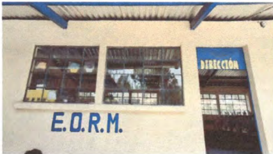
Foto 1: Vista donde se realiza balcones.
