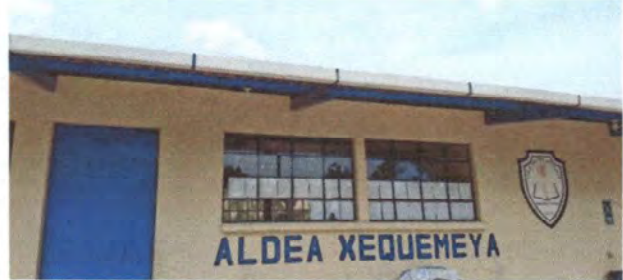
Foto 2: Vista donde se instalará balcones.
