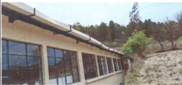
Foto 3: Vista donde se instalará la circulación.
