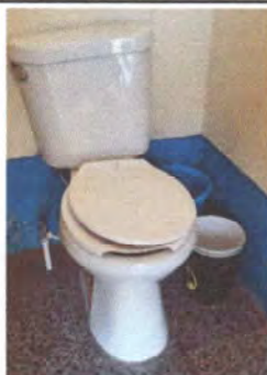
Foto 1: Vista donde se realiza la reparación de accesorios de servicios sanitarios.
