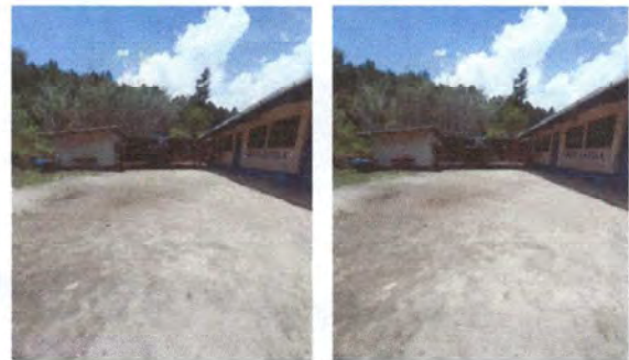
Foto 4: Vista donde se instalará parales de bodega de leña.
