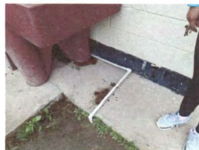
Foto 6: Vista donde se arreglara drenaje de cocina.
