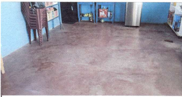
Foto 6. Cambio de piso
