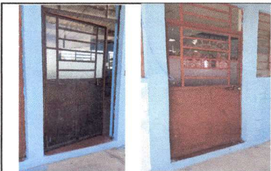
Foto 5. reparacion, pintado y cambio de chapas de puertas
