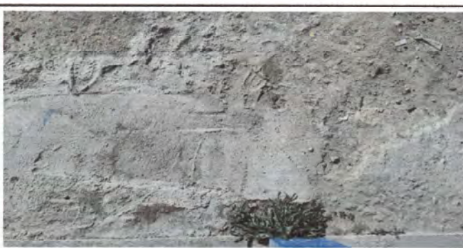
Foto 6: Parches de reparación de losa dañada.
