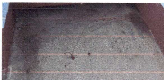
Foto 6: Piso rústico; Instalación de piso de granito
