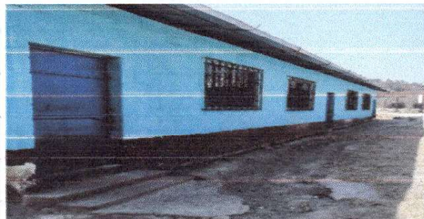
Foto 10 : Acera de las aulas módulo 1; Reposición de piso en mal estado por acera de concreto
